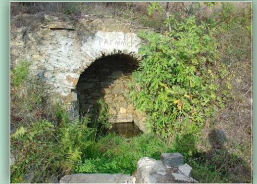
Fonte do Forno da Telha
